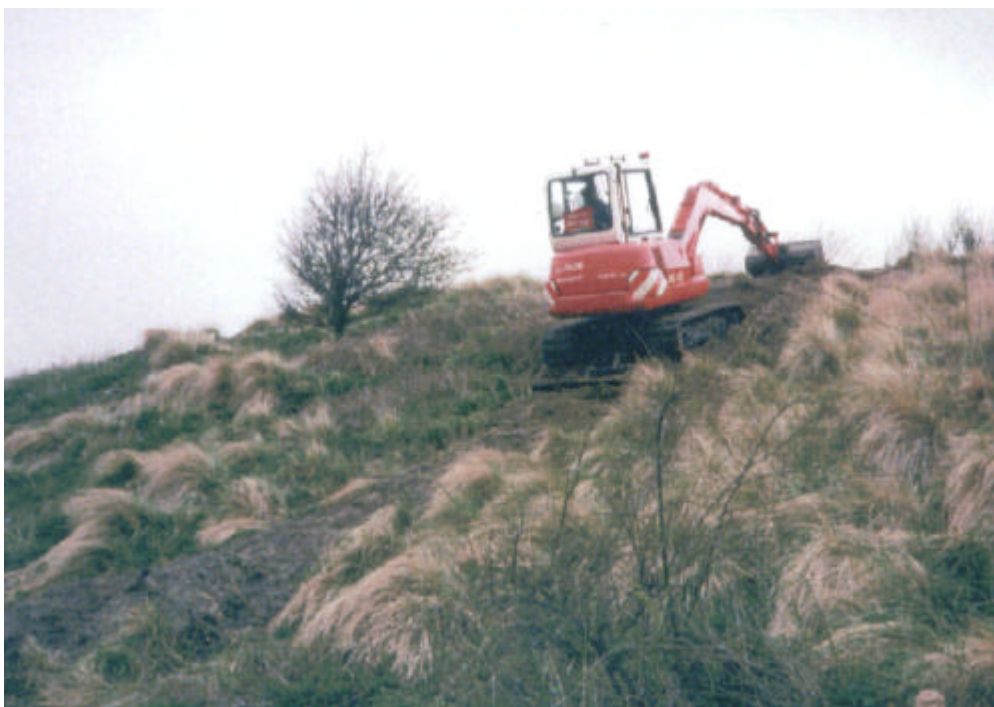
Figuur 3.1 Aanpak van een voormalige stortplaats.
